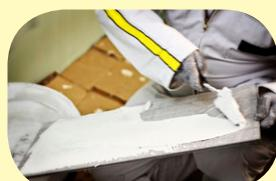
Doporučujeme lepit způsobem oboustranného lepení – tzn. na dlaždici se nanese vrstva lepidla  $1-2\text{ mm}$  silná.
