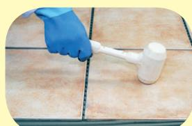
Po osazení dlaždice do lepidla poklepem plastovou palíčkou stabilizujeme dlažbu a vytlačíme vzduch. Spárovací maltu aplikujeme po 24 hod.
