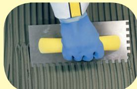
Lepidlo aplikujeme na podklad za použití nerezového hladítka o velikosti zuba  $6 \times 6\text{ mm}$ ,  $8 \times 8\text{ mm}$  nebo  $10 \times 10\text{ mm}$  dle velikosti dlaždic.
