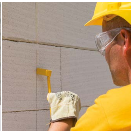
Vytváření drážek pomocí drážkovače představuje jednoduchý úkon.
