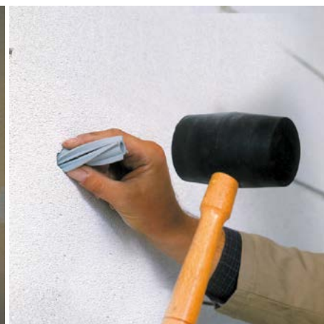
Hmoždinky určené do pórobetonu zaručí spolehlivé kotvení.
