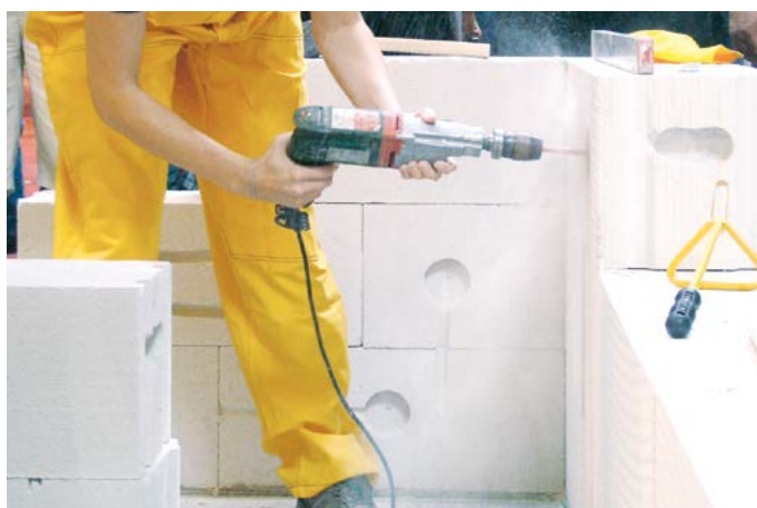
Vrtání do pórobetonu je jednoduché.
