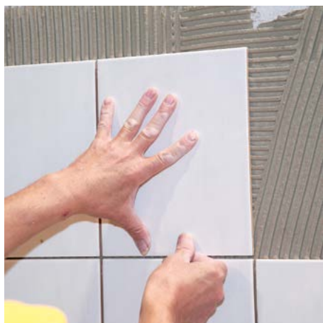
Stěny Ytong můžeme přímo obkládat.
