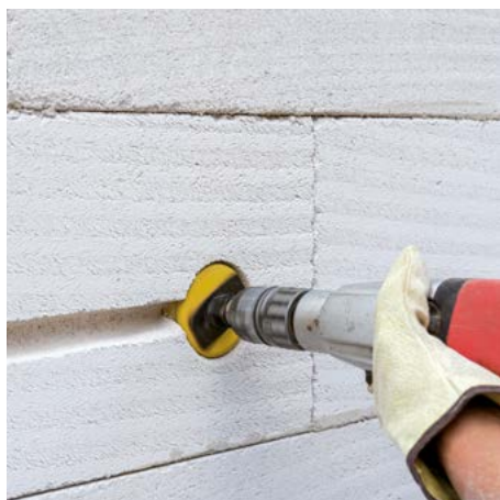
Otvory pro krabice vypínačů se jednoduše navrtají pomocí speciálního vrtáku a vrtačkou bez přiklepu.
