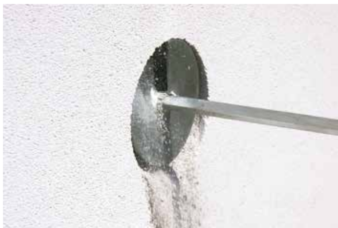
Hloubka vrtání závisí na velikosti budoucí instalační krabice.
