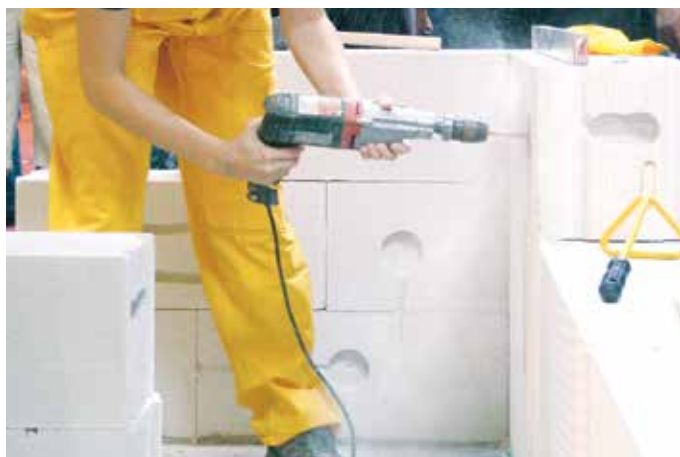
Vrtání do pórobetonu je jednoduché.
