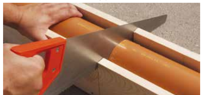
Obrázek 2 Zkracování trubky pilkou
